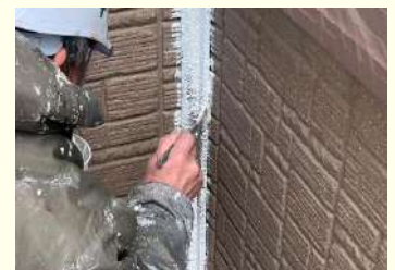
長年の劣化を補修
